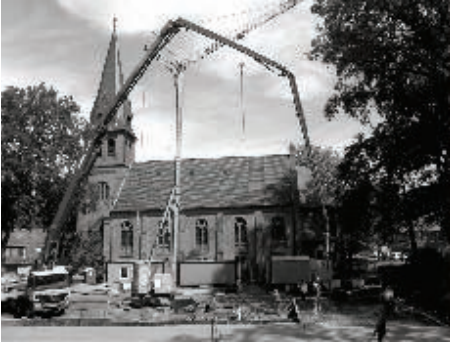
Schütten der Sohle am 1. Juni 2011
