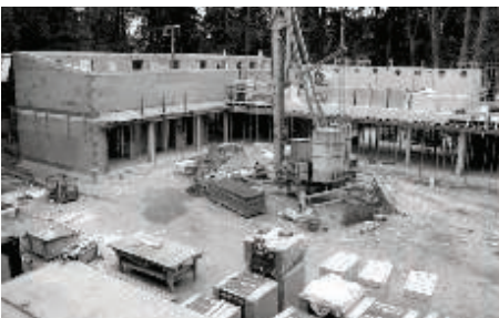
So sah der Rohbau am 22. Juli 2011 aus.
